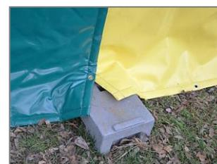
La clef d'une bonne installation est de limiter les 'fuites' acoustiques entre les bâches et par le sol. Attention au sens d'installation, il y a une face avant et une face arrière (absorbant le bruit) !
