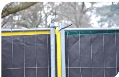
Les bâches acoustiques SONOSCREEN servent à lutter contre la pollution sonore au voisinage des chantiers. Grâce à l'installation simple et rapide, les bâches sont la solution idéale pour confiner le bruit à la source pendant de courtes périodes et pour un prix modeste.
