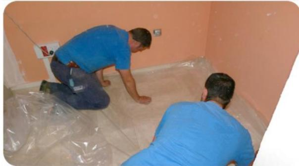
Placement d'un film polyéthylène sur la zone de la dalle structurelle où la dalle Jack-up doit être réalisée, afin d'éviter que le béton de la dalle jack-up soit en contact direct avec la dalle porteuse.
