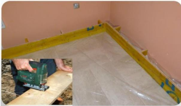
Réalisation du coffrage périphérique, par exemple par des bandes de bois de sapin. Les planches doivent être bien fixées, de manière à éviter leur déplacement lors du bétonnage, par la vibration du béton liquide et la pression du béton.
