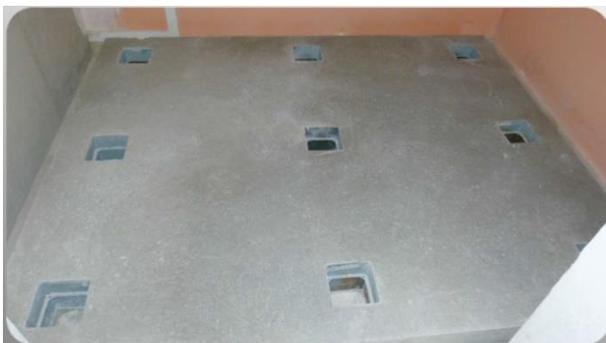
Lissage à niveau de la dalle de béton Jack-up
