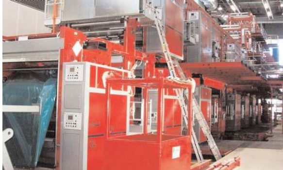
Rotative de presse de 94m de long posée sur fondation isolée Isoblok
