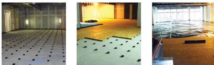
Séquence de mise en œuvre pour un gymnase dans un bâtiment au centre-ville
