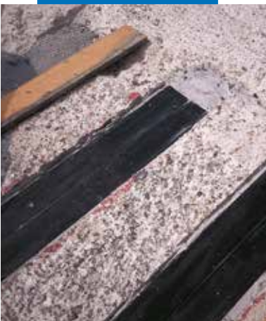
Plats Carboplate engravés dans le béton
