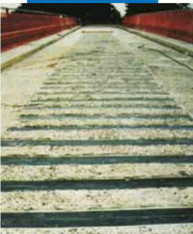
Travée béton renforcée avec les plats Carboplate
