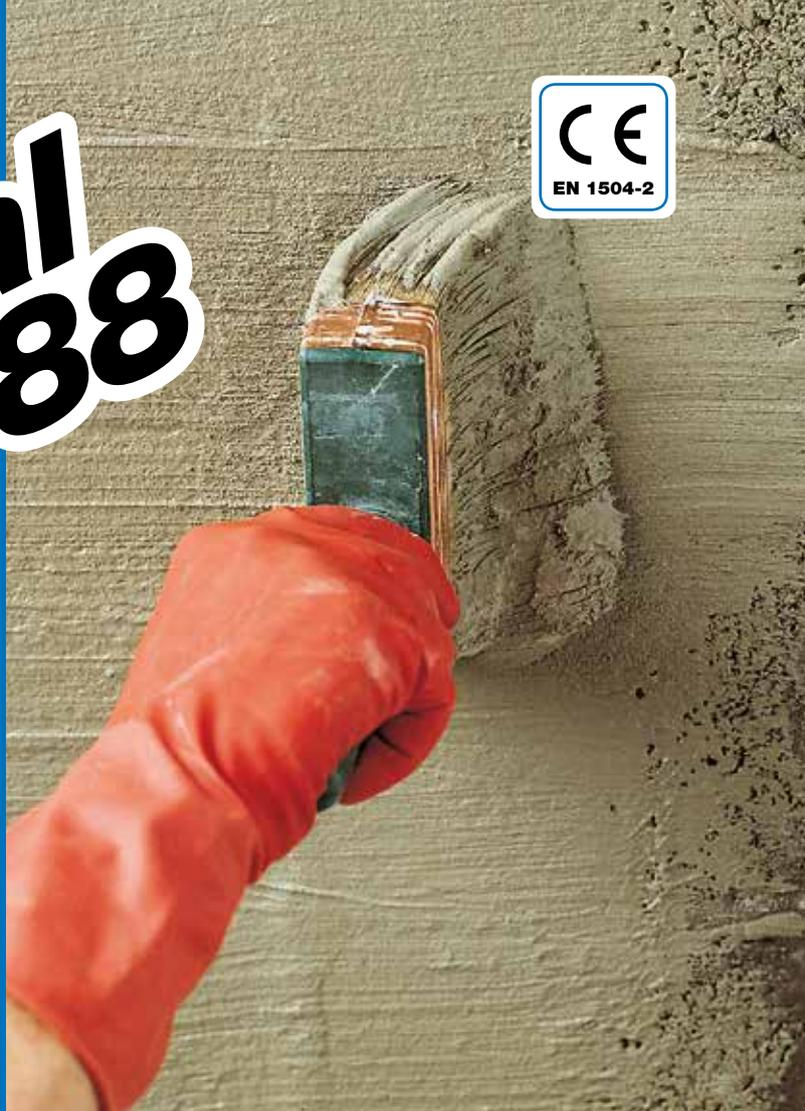
**Mortier cimentaire osmotique adapté au contact avec l'eau potable, pour l'imperméabilisation de maçonnerie et de constructions en béton**
