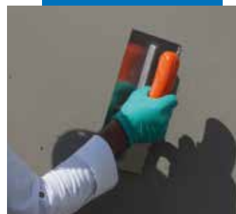
Application de la 1 ère passe à la spatule, 2 ème passe après 1 h (à +20°C)
