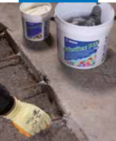
Bevestigen van wapeningsstaven voor het maken van een deuvelverbinding met Adesilex PG1
