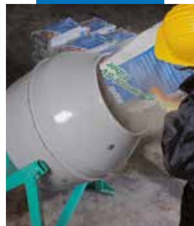
Bereiden van het Mapegrout SV Fiber-mengsel
