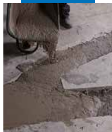
Aanbrengen van Mapegrout SV Fiber in een te herstellen deel
