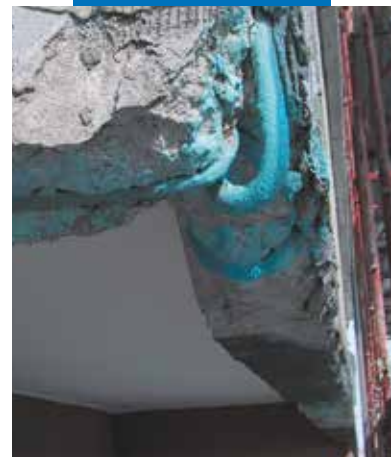
Wapeningsstaven aan de voorzijde van een balkon behandeld met Mapefer 1K
