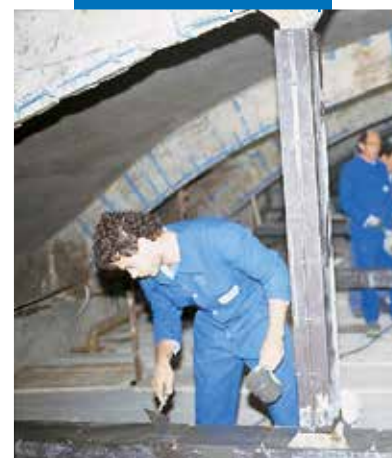
Coulage de Mapegrout Colabile dans un coffrage métallique
