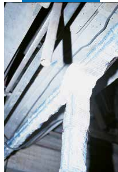
Structure en béton dégradée
