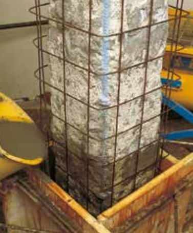
Coulage dans un coffrage
