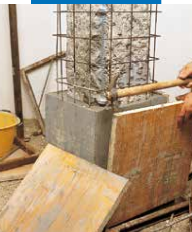
Décoffrage (coffrage en bois)
