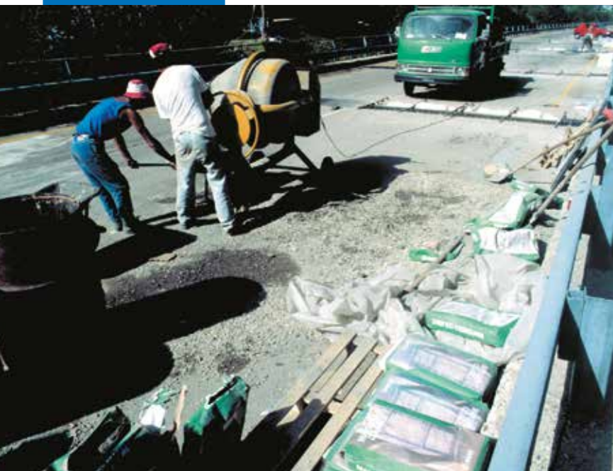
Rénovation de joints routiers
