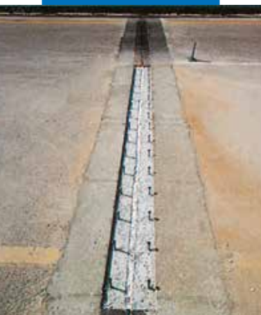
Herstellen van een verbinding in een verkeersbrug met Mapectill
