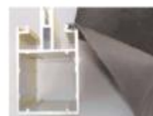
EPDM voorzien van clips volgens het timmerwerkprofiel
