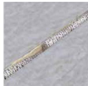
③ La jonction est réalisée par recouvrement d'au moins 20 cm. Si nécessaire, placer le mastic Jointofeu pour terminer le joint.
