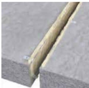
① Enduire les bords des dalles béton d'une couche de colle jointofeu.
