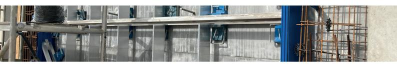
Principe d'extensions sur profils Omega 3 en 160, 180 et 200
