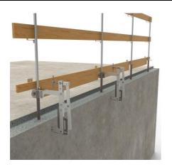
Pour le coffrage des rives, fixer les GDR sur le tube acier dépassant.
