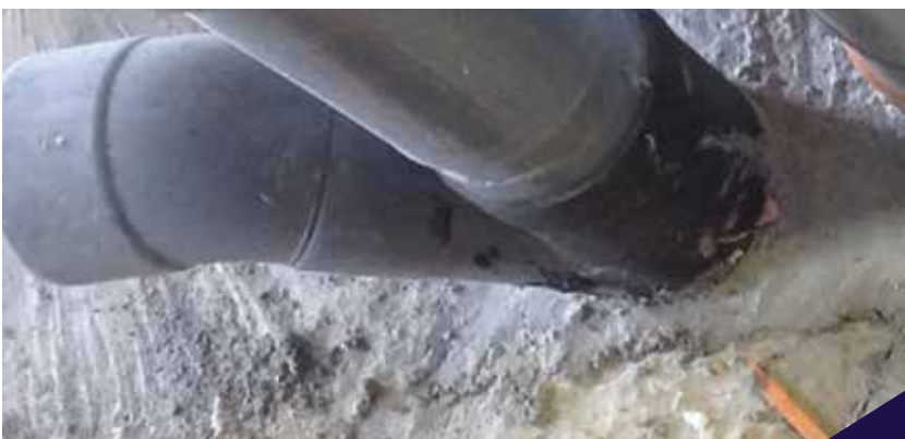
Doorboring van de bodem en kokerdoorvoeringen.
