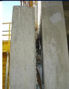
Après décoffrage des banches, retirer les tubes pvc 26/30 avec un chasse tube. Injecter abondamment l'eau dans la structure alvéolaire du Plakamur. La structure percée facilite la diffusion de l'eau.
