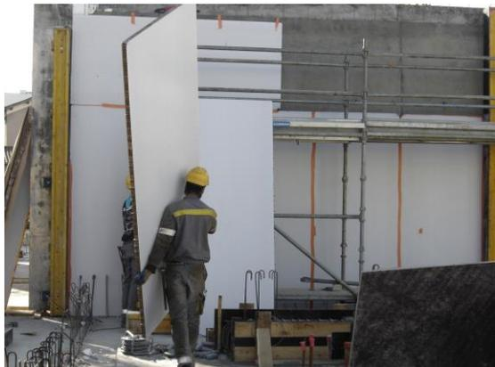
Poser les panneaux bord à bord contre le voile déjà coulé. Veiller à ce que le sol soit sec. Scotcher les jointures entre panneaux ainsi que les tranches visibles aux extrémités. Recouvrir de scotch toute déchirure éventuelle qui pourrait se produire en phase de ferrailage.
