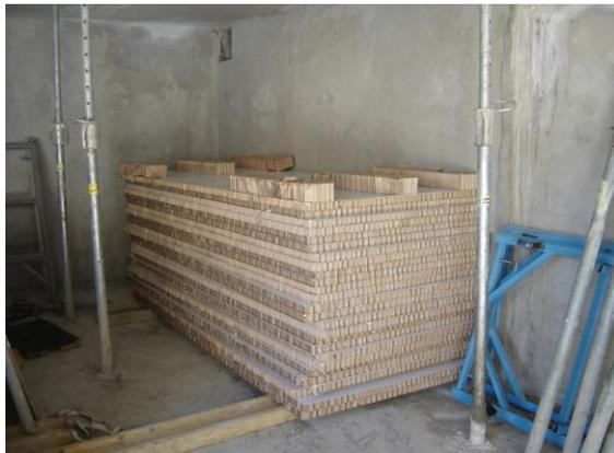
Le Plakamur doit être stocké à plat, au sec, avec circuit d'aération si le produit est recouvert d'une bâche (par en dessous et au dessus).
