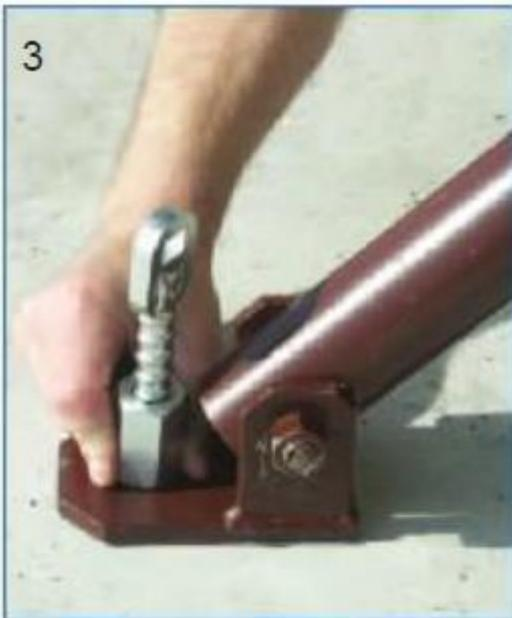
3. serrer le contre écrou à la main sur la platine de l'étau
