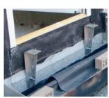
Nous conseillons de placer les Solea-Fix à 20-30 cm du bord du seuil (1/5 ème de la portée).
