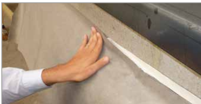
Korbo Dry is eenvoudig aan te brengen op de ondergrond.
