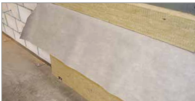
Nadat de afdichting is aangebracht, kan men de rest van de isolatie plaatsen.
