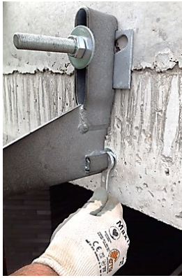
Photo 4: Réglage des consoles KORBO
