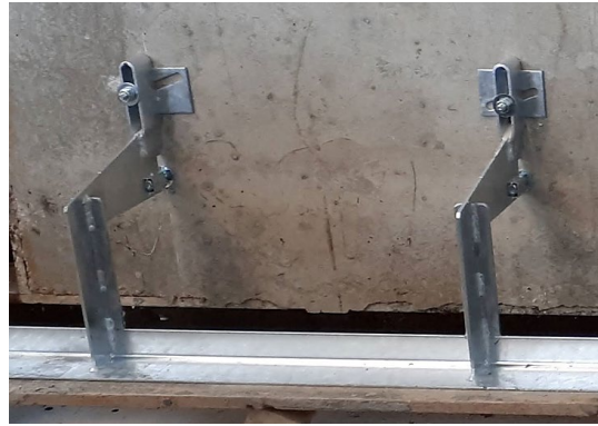
Photo 3 : Support de maçonnerie KORBO avec battée renforcée
