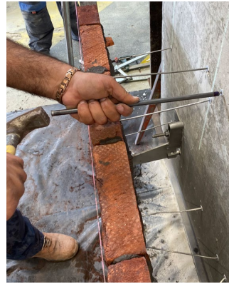
Photo 6: Installation des attaches murales avec l'outil
