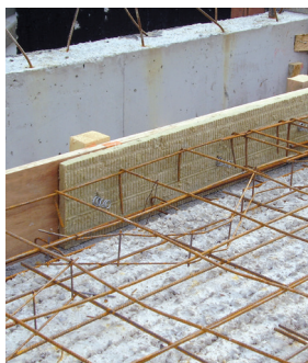
1 Clouage des bandes sur le coffrage de rive.
