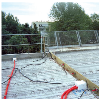
1 Mise en œuvre des Goujons Titan 1ère phase.
