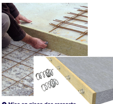
2 Mise en place des ressorts.
