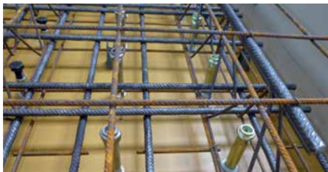
MONTAGE VAN BEVESTIGINGSANKERS
