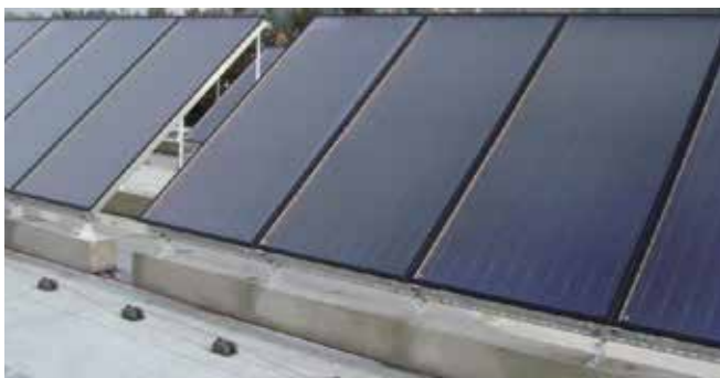
BEVESTIGING VAN ZONNEPANELEN
