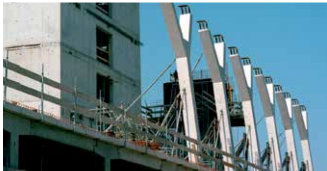
STELLEN EN BEVESTIGEN VAN PREFAB ELEMENTEN
