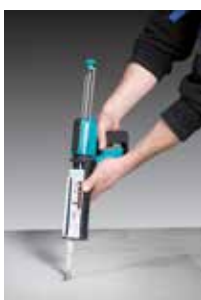
Injecter à reculons
