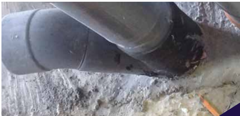
Perçage du fond et passage des gaines.
