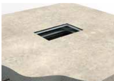
Retrait du couvercle en OSB. Ne pas enlever la ceinture ni le fond coffrant.
