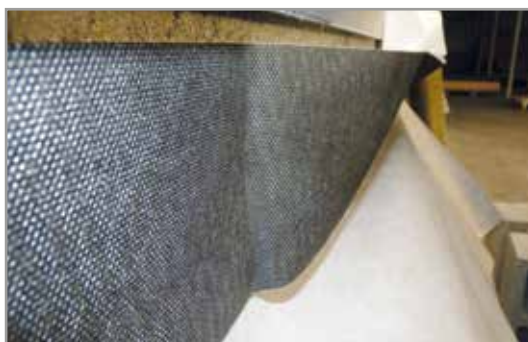
La bande Korbo dry+ est placée au dessus du Korbo Dry.
