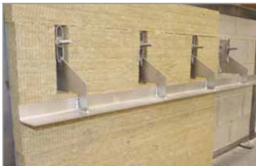
Placement d'une cornière de support de maçonnerie Korbo
