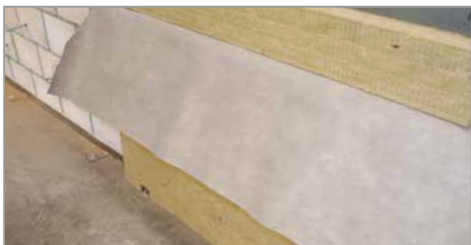
Après que les membranes soient placées, le reste de l'isolation peut être mise en place.
