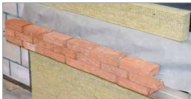
Le Korbo Dry sera placé dans le premier joint horizontal libre. C'est par là que l'écoulement éventuel se réalisera.
