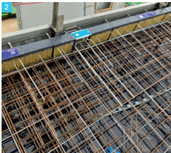
1 Mise en œuvre des rupteurs Isotec RT+ en ITI
